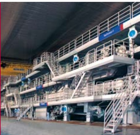
Kuva 1: Formaatiomittaukset voidaan tehdä monikerrospapereiden valmistuslinjan kaikissa perälaatoissa.
