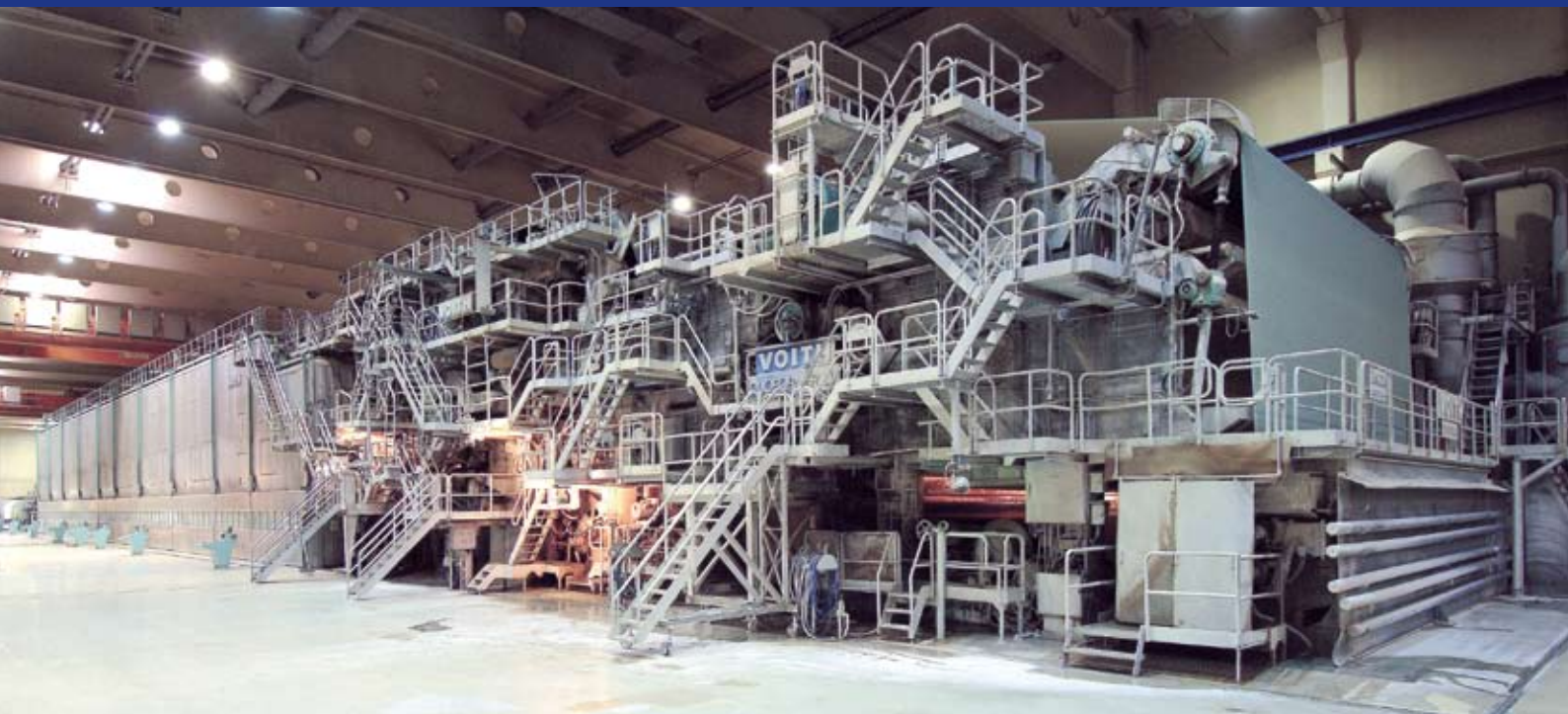
Die PM 4 bei UPM Steyrmühl wurde auf das moderne DuoFormer CVB Konzept umgerüstet.
