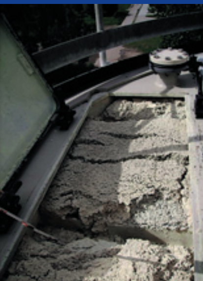
Verstopfung der Ablaufwehre am Reaktorkopf
